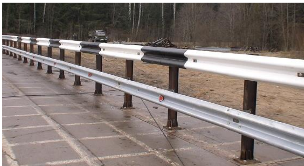
Рисунок 13. Защитные пластиковые панели вертикальной дорожной разметки
