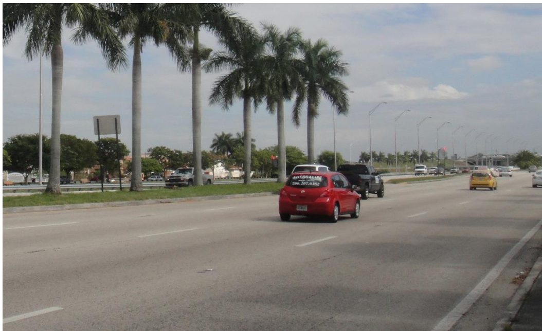
Рисунок 3. Отсутствие контрастности дорожной разметки на цементобетонном покрытии (фото авторов)
