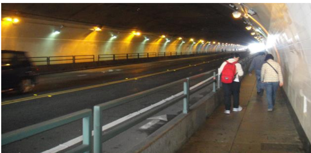
Рисунок 2. Разметка, применение катафотов и освещение в тоннеле (г. Сан-Франциско [2])
