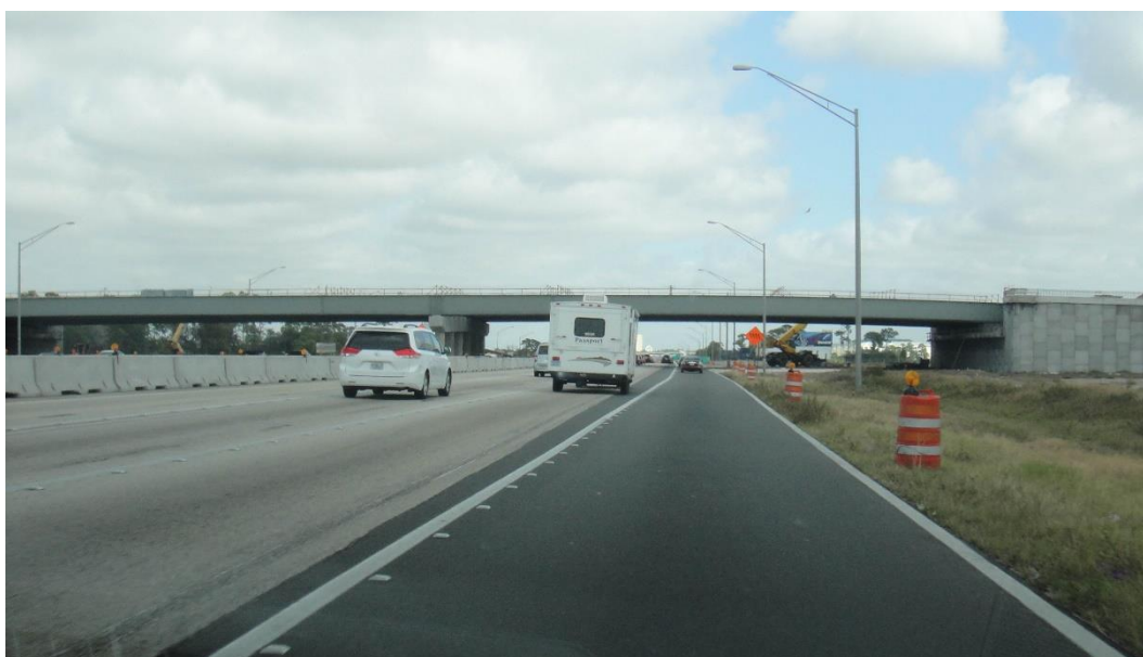
Рисунок 4. Разница контрастности разметки на цементобетонных и асфальтобетонных дорожных покрытиях (фото авторов)
