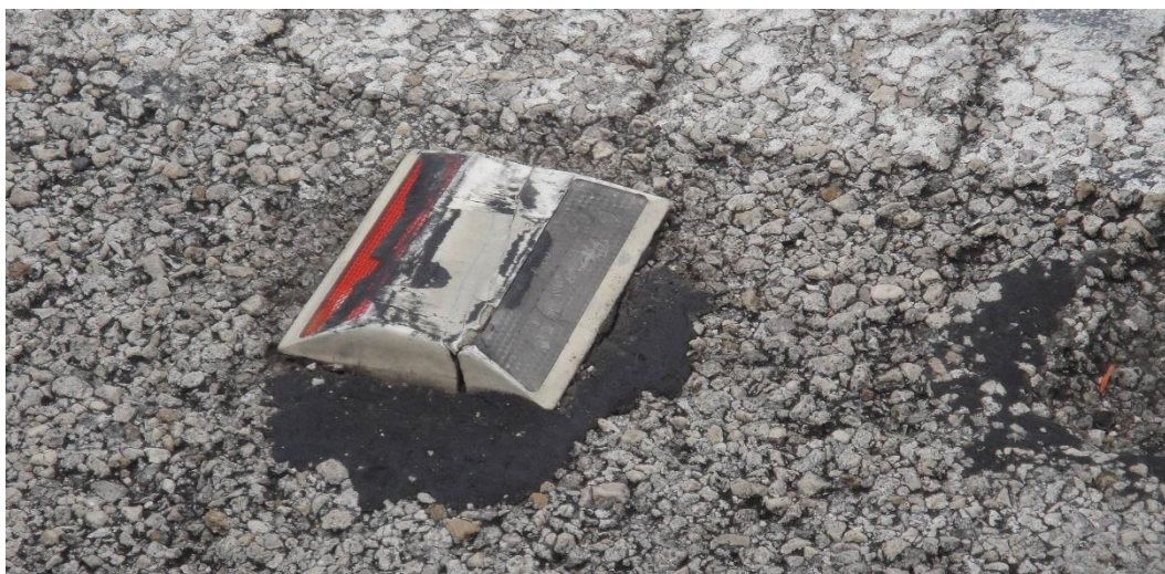
Рисунок 8. Совмещение старой дорожной разметки с применением катафотов (фото авторов)
